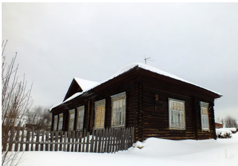
Здание школы в д. Чёрная.
